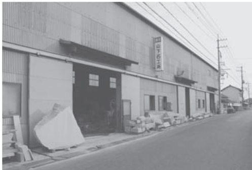
ワイヤソー、大口径、中口径、オフカット、自動・手動研磨機などの機械類を揃えて、いまも現役で稼働する工場。蓮華などの役モノも自社で加工する
